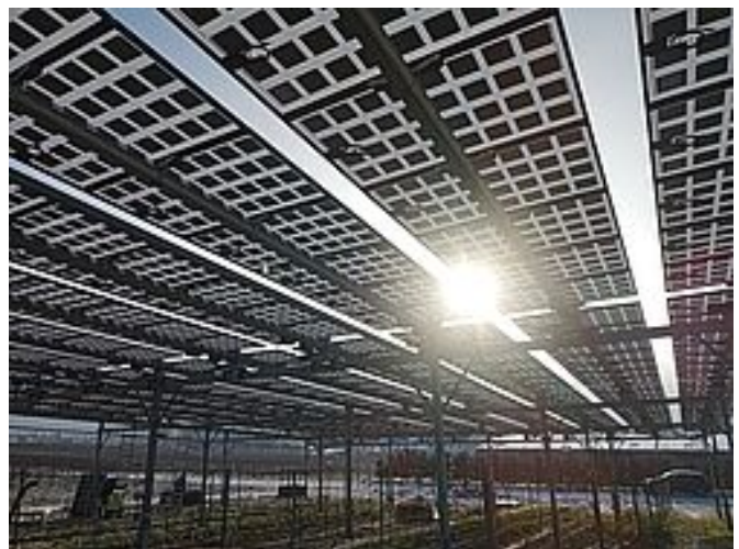
Die PV-Module der „VitiVoltaic“ Anlage sind semi-transparent und bifazial, d.h. sie lassen
